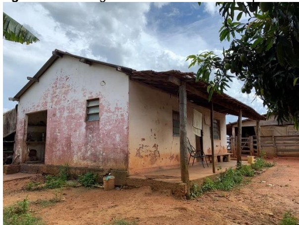
Figura 03: Vista geral da residência da propriedade.
