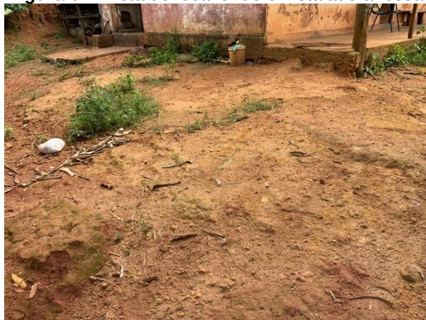
Figura 04: Vista do local onde é instalado a fossa.
